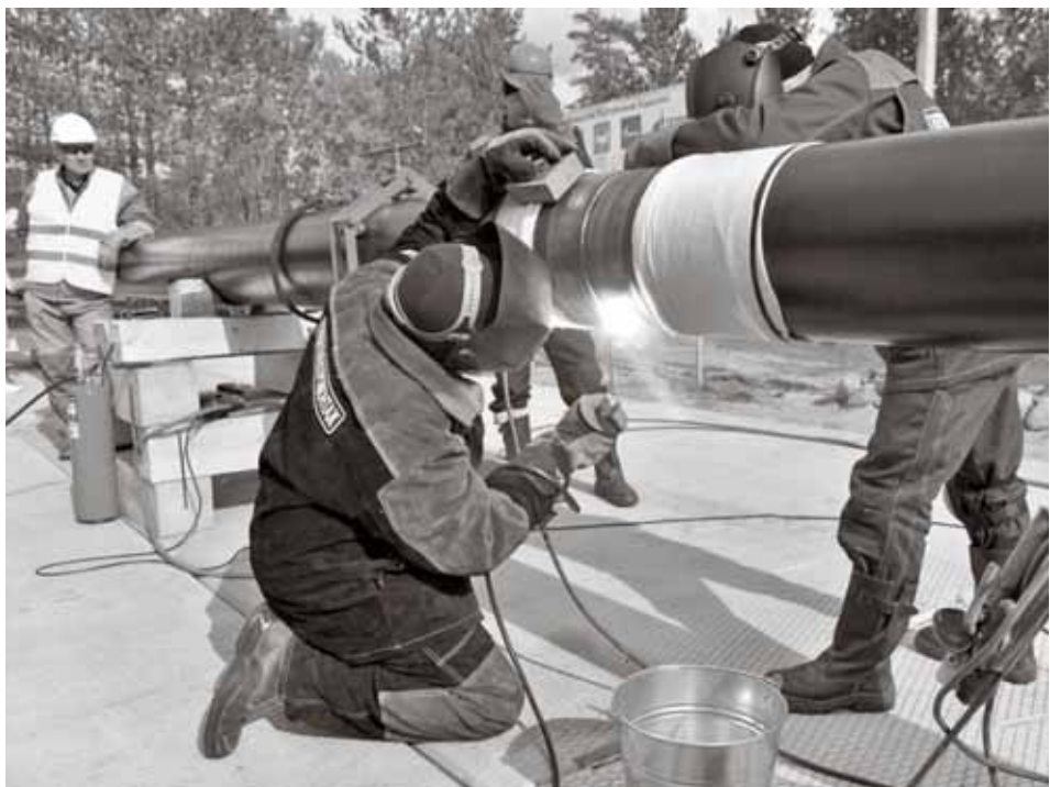
Сварка первого шва газопровода «Олонец – Питкяранта». Фото: «Республика»/Сергей Юдин
